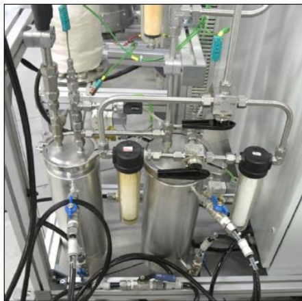
Figura 21. Depósitos de condensación de líquidos y sistema de filtros.
