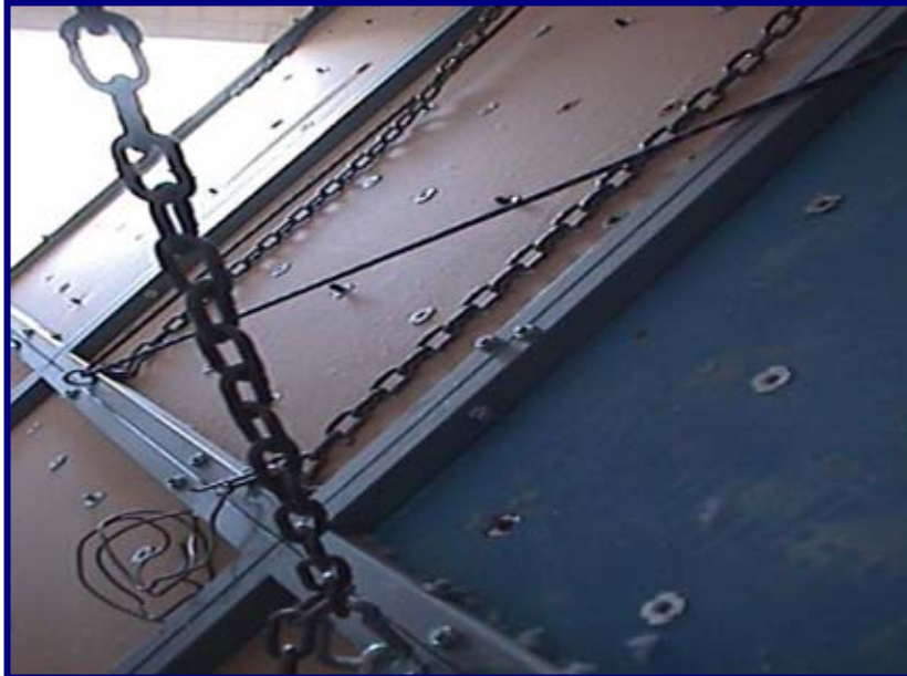
Rocódromo vista posterior, estructura, tensores, cadenas y arañas para presas.
