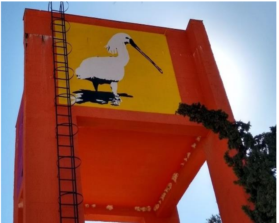
Imagen 3.142.- Depósito de agua
