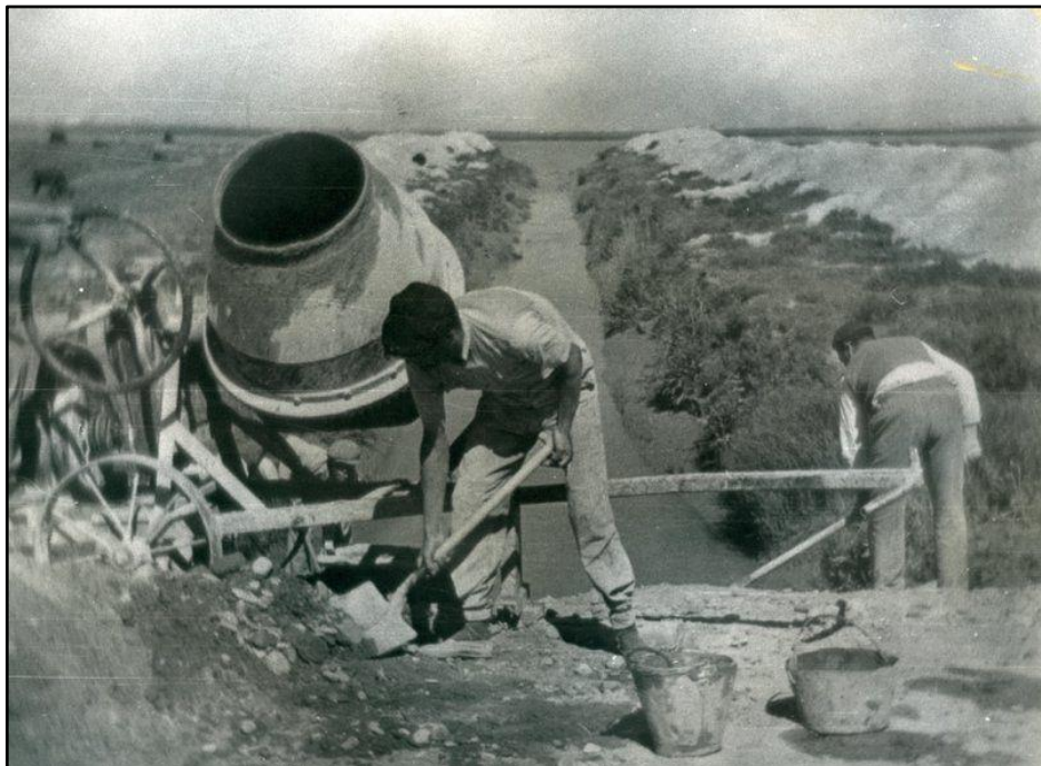
Imagen 3.32.- Obras de canalización
