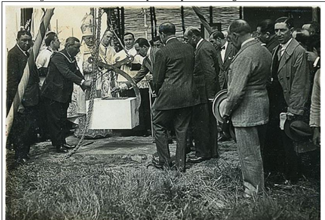
Imagen 3.17.- Colocación de la primera piedra de la iglesia del Carmen
