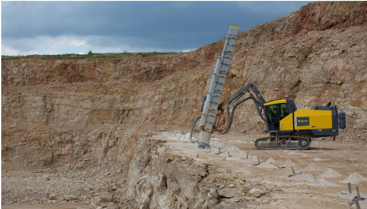
Figura 8. Perforación en una mina a cielo abierto. Tomada de Epiroc (2022).
