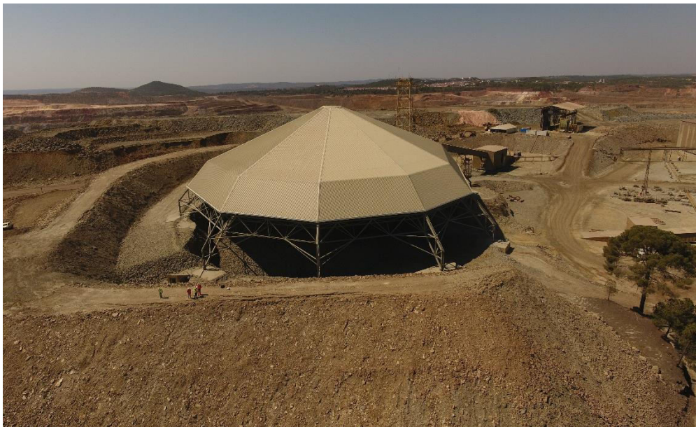
Figura 24. Acopio con cubierta y con barreras verticales contra el viento en una mina a cielo abierto. Fuente propia.
