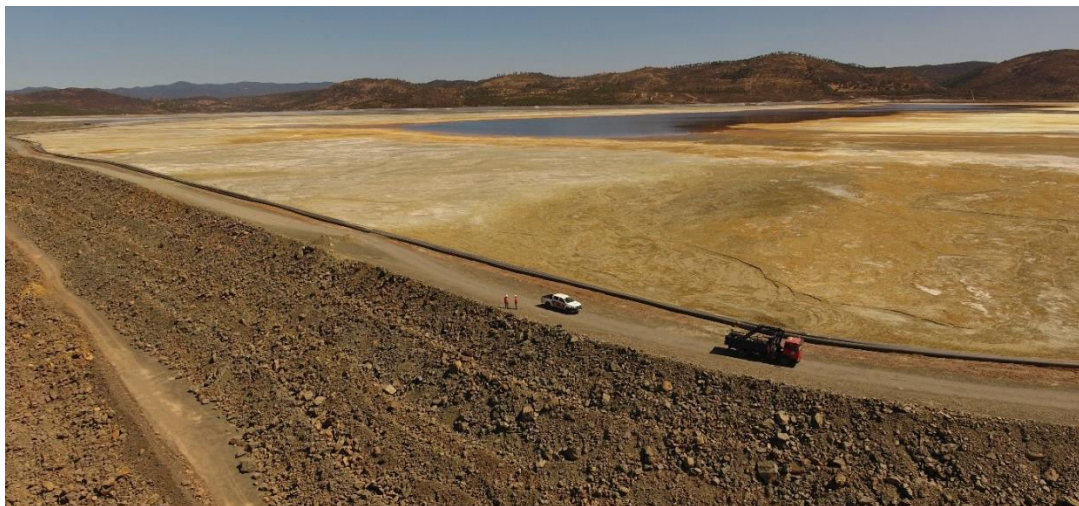
Figura 18. Presa de lodos en una mina a cielo abierto. Fuente propia.
