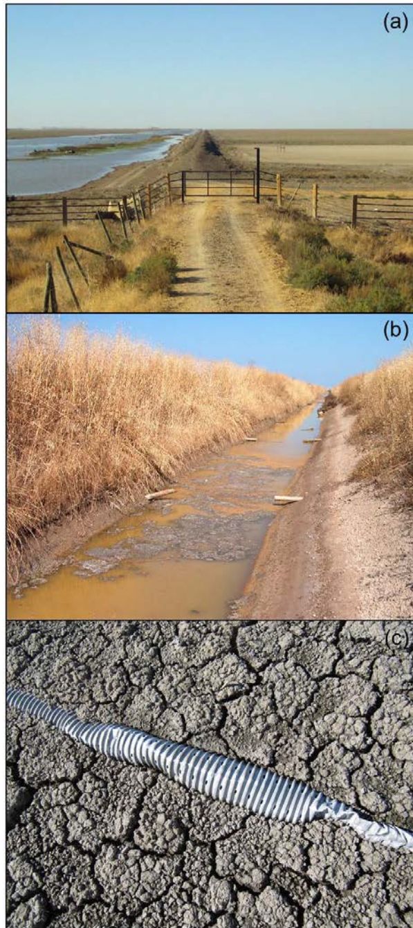
Figura 1.3. Fotografía de (a) un dique perimetral impidiendo la entrada de agua desde Entremuros (a la izquierda), (b) un canal artificial de drenaje recibiendo el agua recogida por los “catufos” y (c) un tubo permeable subterráneo desenterrado donde se aprecian los orificios por donde captan el agua filtrada del terreno.
