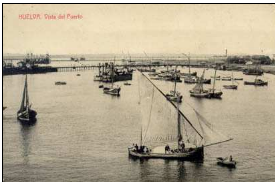
Fotografía 6.23.- Vista de la ría de Huelva (A.M.H. Fondo Díaz Hierro. Archivo, cpt. 3192).
