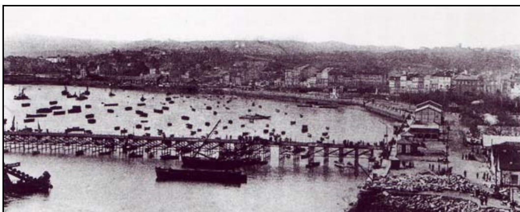
Fotografía 2.15.- Muelle de Hierro en el Puerto de La Coruña (PARRILLA, J.A.: Op. cit. ).
