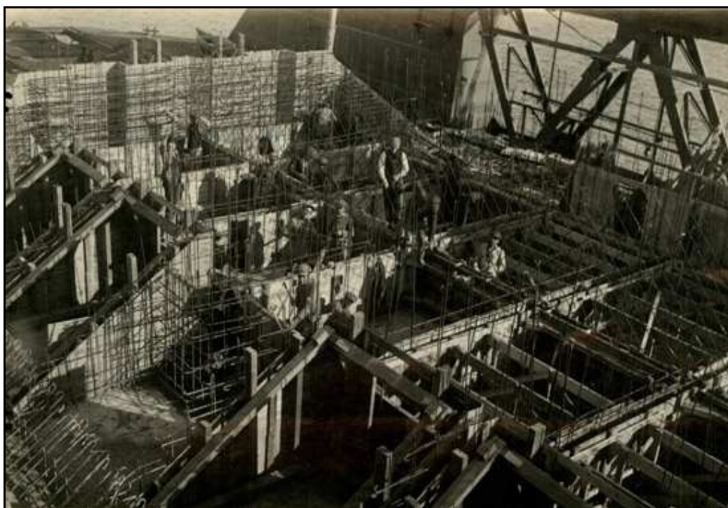
Fotografía 6.1.- Construcción del Muelle de fábrica (A.P.H.).
