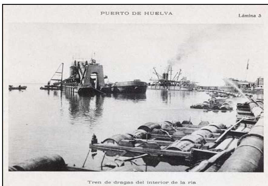
Fotografía 4.2.- Tren de dragado del Puerto de Huelva (A.P.H. Memoria sobre el estado y adelanto de las obras, 1904-1913..., leg. 2251).
