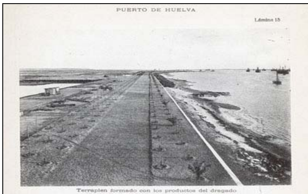
Fotografía 5.6.- Avenida Francisco Montenegro recién terraplenada, principios del siglo XX (A.P.H. Memoria sobre el estado y adelanto de las obras, 1904-1913..., leg. 2251).
