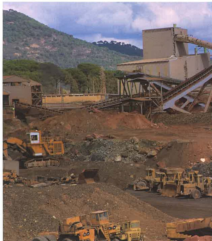
Trabajos en las minas
