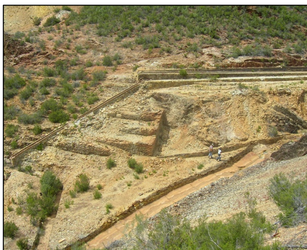
Figura 5. Antiguo sistema de canaleo en la mina de Tinto Santa Rosa.
