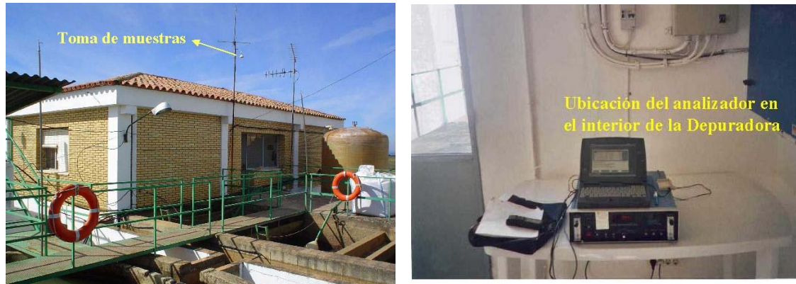
Figura 3.18. Imágenes de la estación de medida de Valverde.
