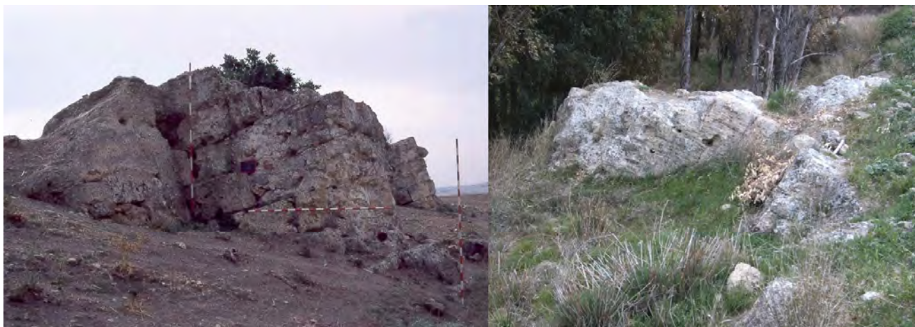
Fig. 2. Derecha. Torres 4 y 5 del circuito amurallado de Tejada (la Nueva) en el año 1996 (Vidal Teruel 2007, 417). Izquierda. Estado de las estructuras en 2012 (Fotografía de la autora).
