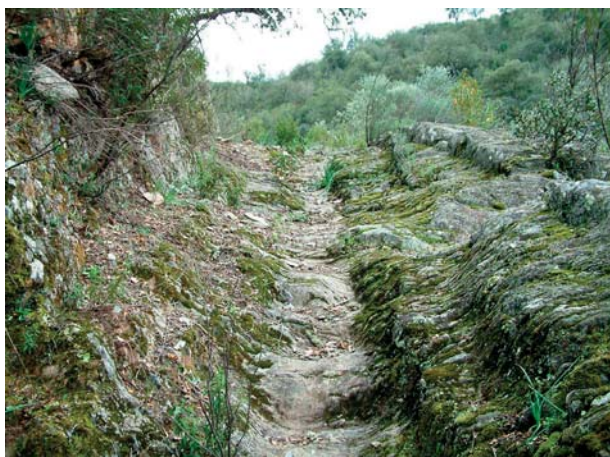
Figura 10. Trinchera del Camino del Moro en Berrocal.
