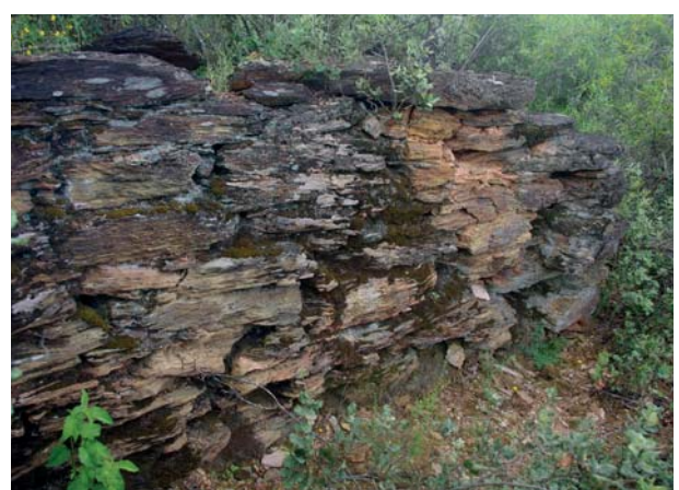
Figura 6. Detalla del aparejo de los muros de la fortificación de Barranco Abadejo.
