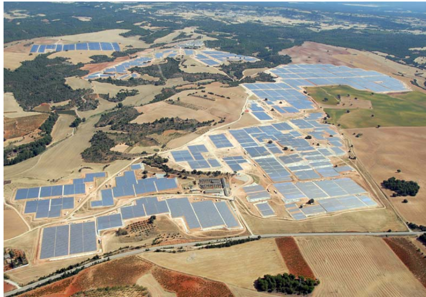
Figura 2.8 Planta solar de Olmedilla de Alarcón (Cuenca), construida en septiembre de 2008. Ocupa 50 hectáreas con una potencia instalada de 60 MWp y una capacidad de 85 GWh. Fuente: NOBESOL.
