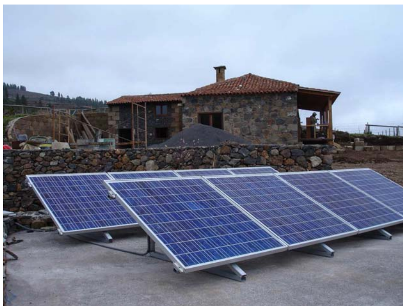
Figura 2.17 Fotografía de vivienda y sistema FV aislado de la red de distribución.
