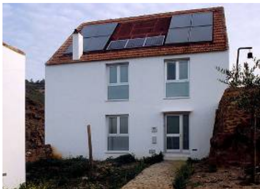
Figura 4. Casa de las Letrinas.
