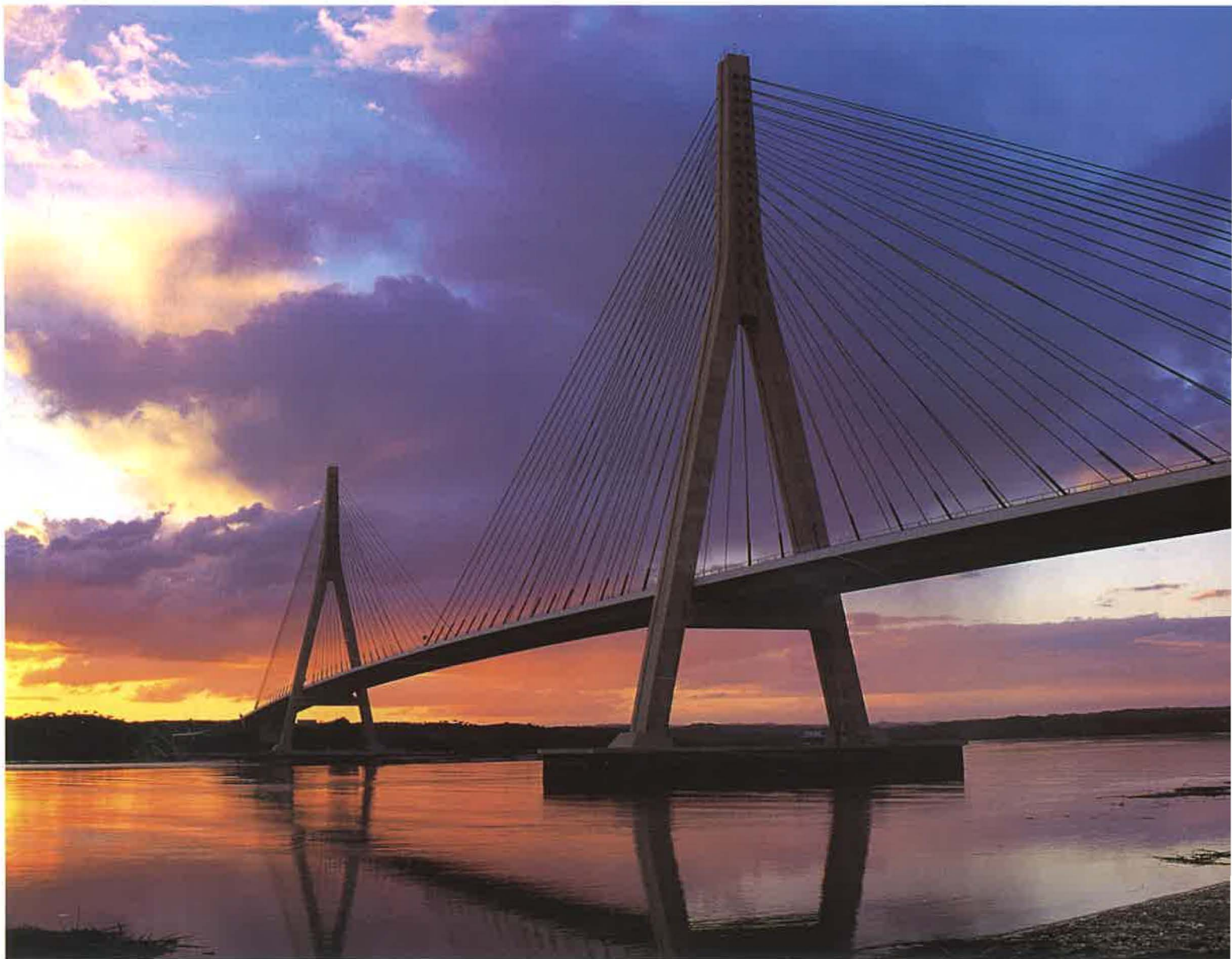
Puente Internacional del Guadiana. Desde su inauguración en 1991 ha modificado positiva y radicalmente las comunicaciones en el Suroeste peninsular
