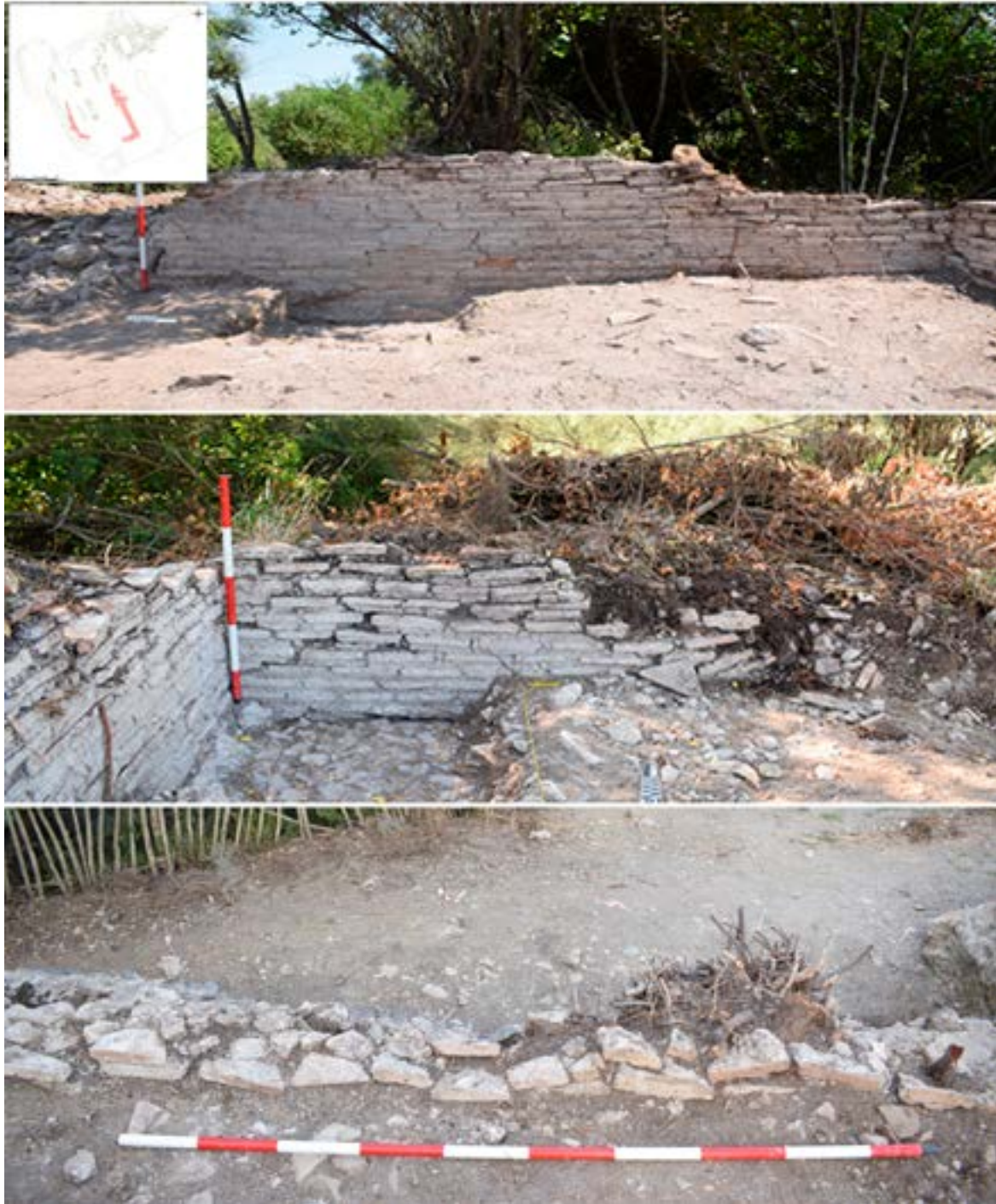
Figura 16. Obra de opus testaceum correspondiente a la nueva infraestructura que ocupó la cabeza del muelle durante esta fase.
