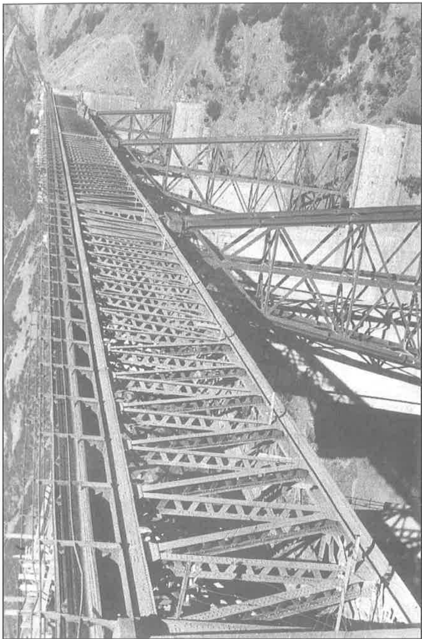
Puente metálico sobre el Odiel. P.K. 151/200. Obras de mejora (1954-56)
