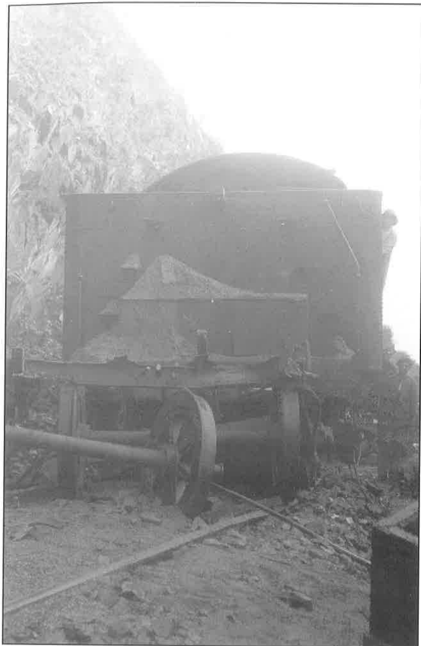
El Tramo de mayor dificultad de toda la línea es el de Jabugo-Valdelamusa. Históricamente la orografía, y las fuertes lluvias provocan desprendimientos, de rocas de las escarpadas trincheras con los consiguientes perjuicios para el tráfico. Cesión de Isabel Naylor Moreno
