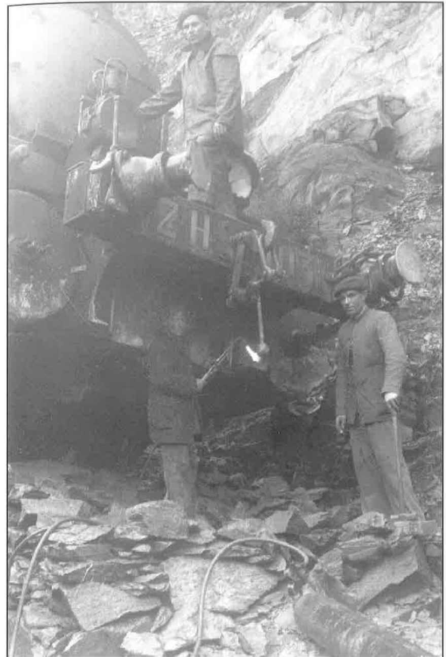
Descarilamiento de la locomotora 103 causado por un derrumbamiento de trinchera entre Valdelamusa y Almonaster en 1941 Cesión de Isabel Naylor Moreno
