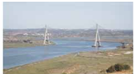
Figura 19. Puente Internacional sobre el Guadiana
