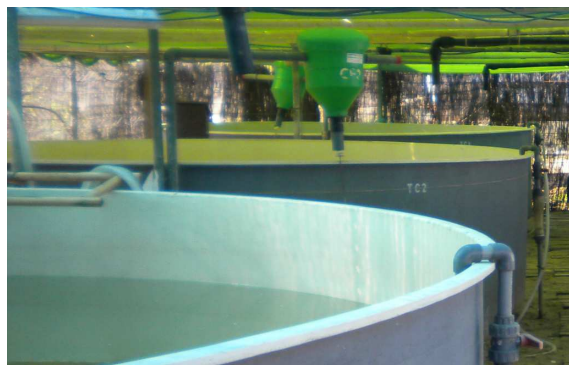
Figura 3.1. Depósitos para la decantación y almacenaje del agua de mar para los cultivos.
