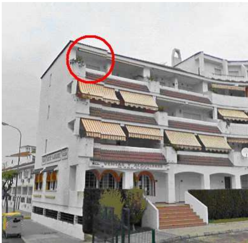
Figura 3.6. Punto E-3 de la monitorización, próximo a la A-5052.
