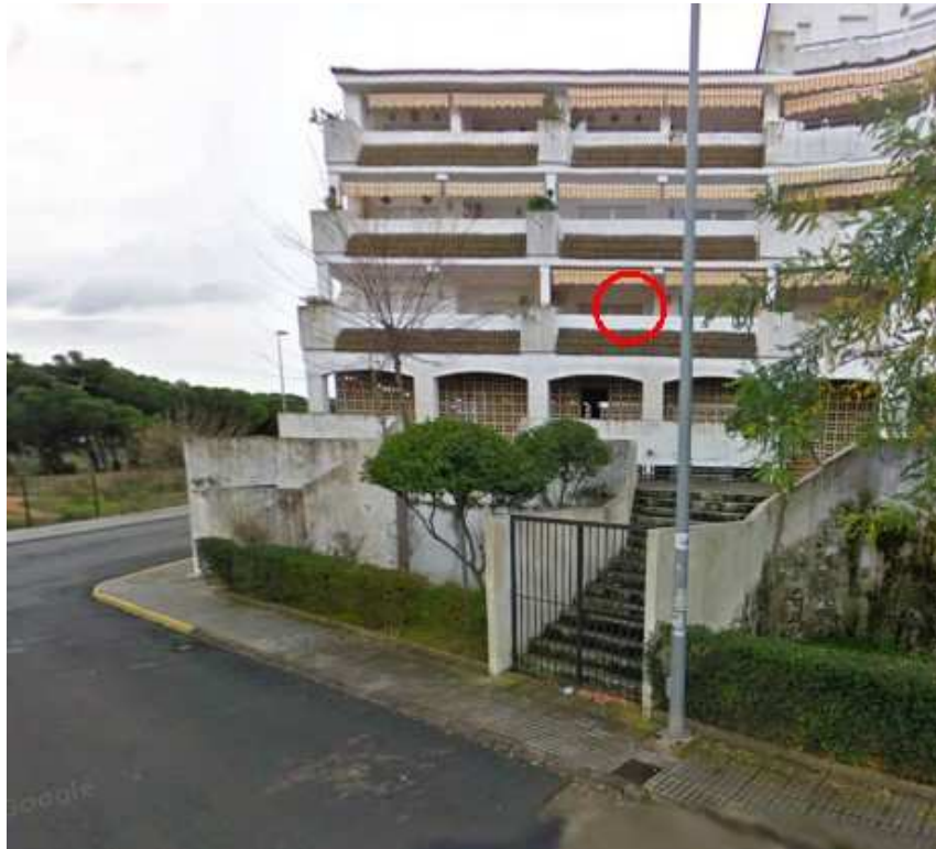
Figura 3.5. Punto E-1 de la monitorización, próximo a la c/ Avoceta.
