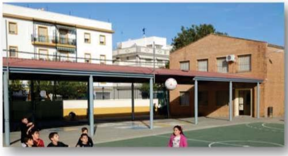
Figura 3. Zona cubierta del patio de educación primaria (Fuente: Propia)
