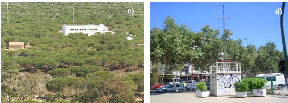
Figura 3.6 (continuación): a) Vista de la estación de Marconi, Cádiz. b) Vista de la estación de Asomadilla, Córdoba. c) Vista de la estación de El Arenosillo, Huelva. d) Vista de la estación de Torneo, Sevilla.
