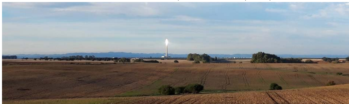
FIGURA 1D PLANTA TERMOSOLAR GEMASOLAR (FUENTES DE ANDALUCÍA, SEVILLA).
