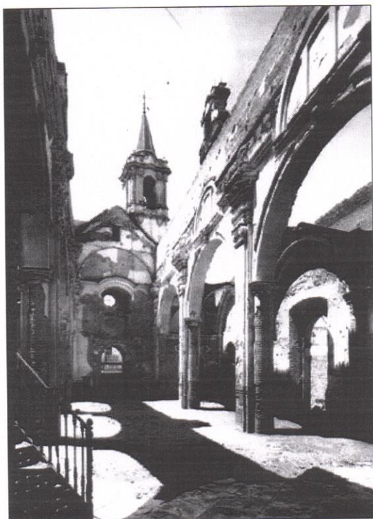
Fig. 1. Iglesia de la Concepción, Huelva. Estado del edificio tras los estallidos de violencia producidos al inicio de la guerra (Biblioteca Nacional, Guerra Civil, carpeta 144).
