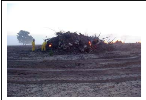
Operarios prendiendo un montón de tocones. Se observa el acerado perimetral.
