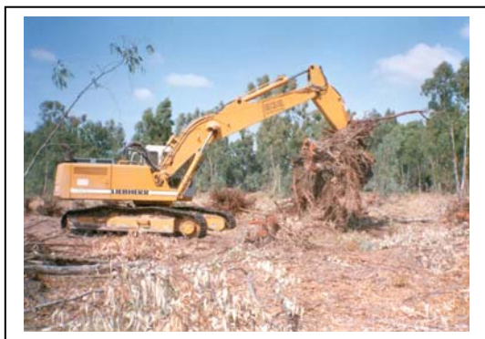
Retroexcavadora destocando.
