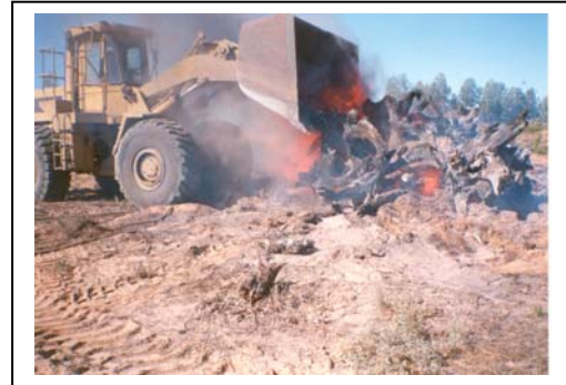
Pala excavadora atizando el motón de tocones para su mejor combustión.
