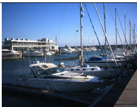
Puerto deportivo de Barbate
