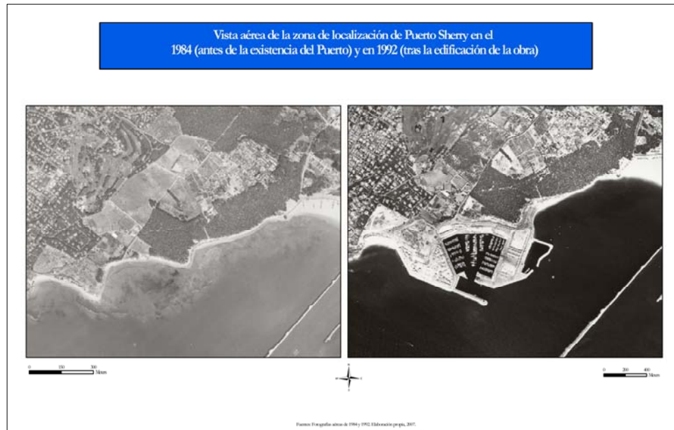
Imagen 7.4. Vista aérea del entorno de Puerto Sherry antes y después de la aparición de la obra
