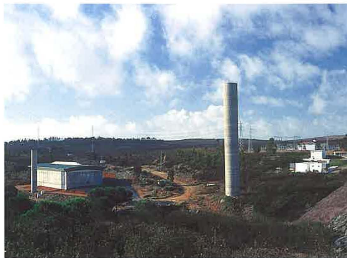
Instalaciones en la Presa de los Machos. Lepe
