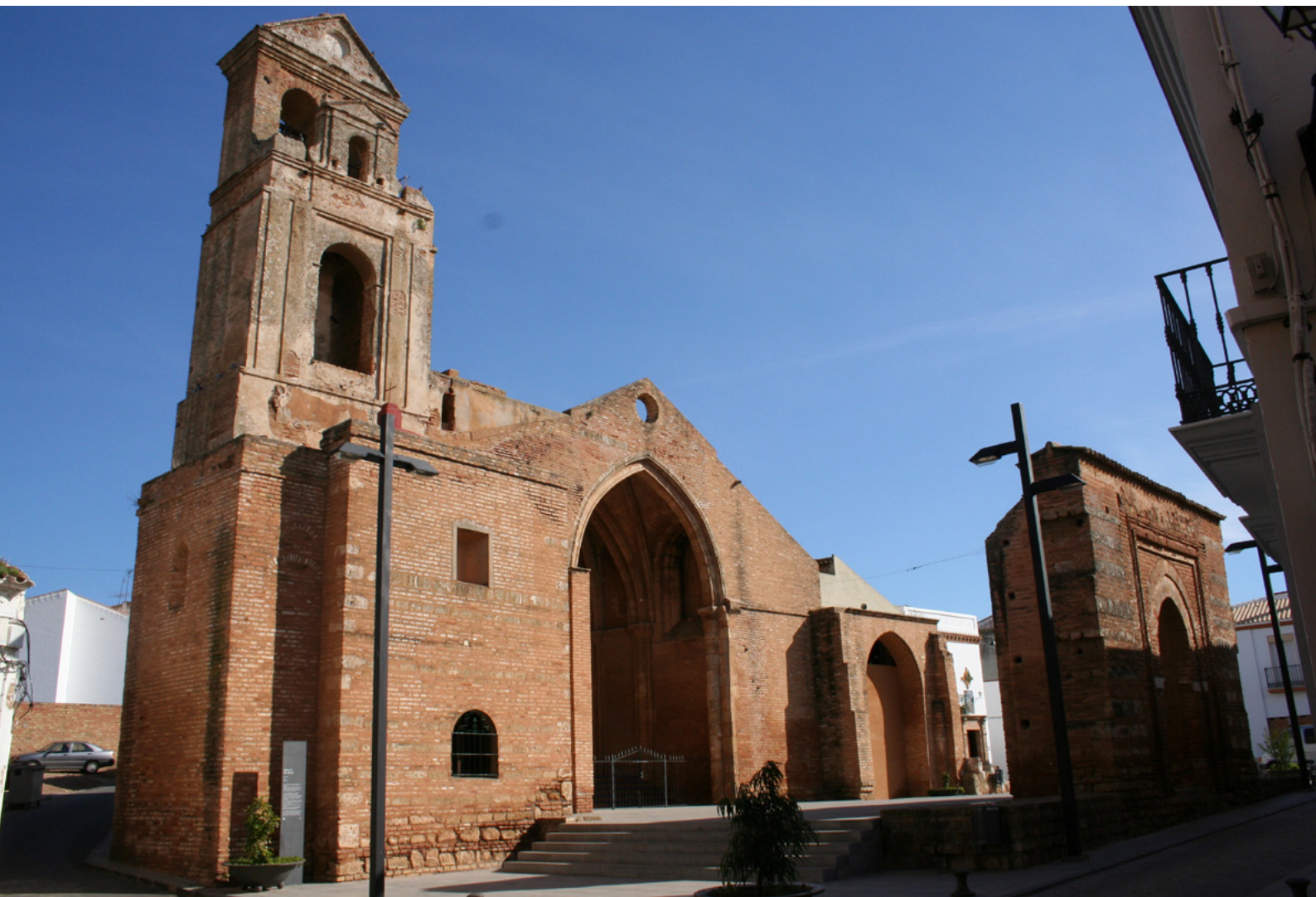
Estado actual de la iglesia de San Martín | foto todas las imágenes, salvo cuando se indique lo contrario, pertenecen al Archivo del Grupo de Investigación Urbanitas: Arqueología y Patrimonio
