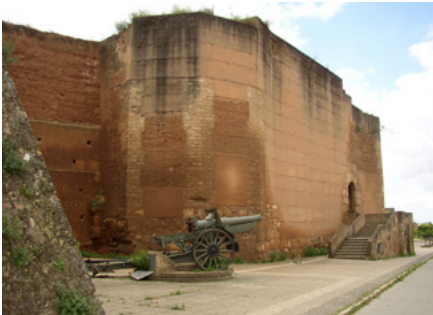
Puerta monumental romana modificada en época almohade, vista desde el este
