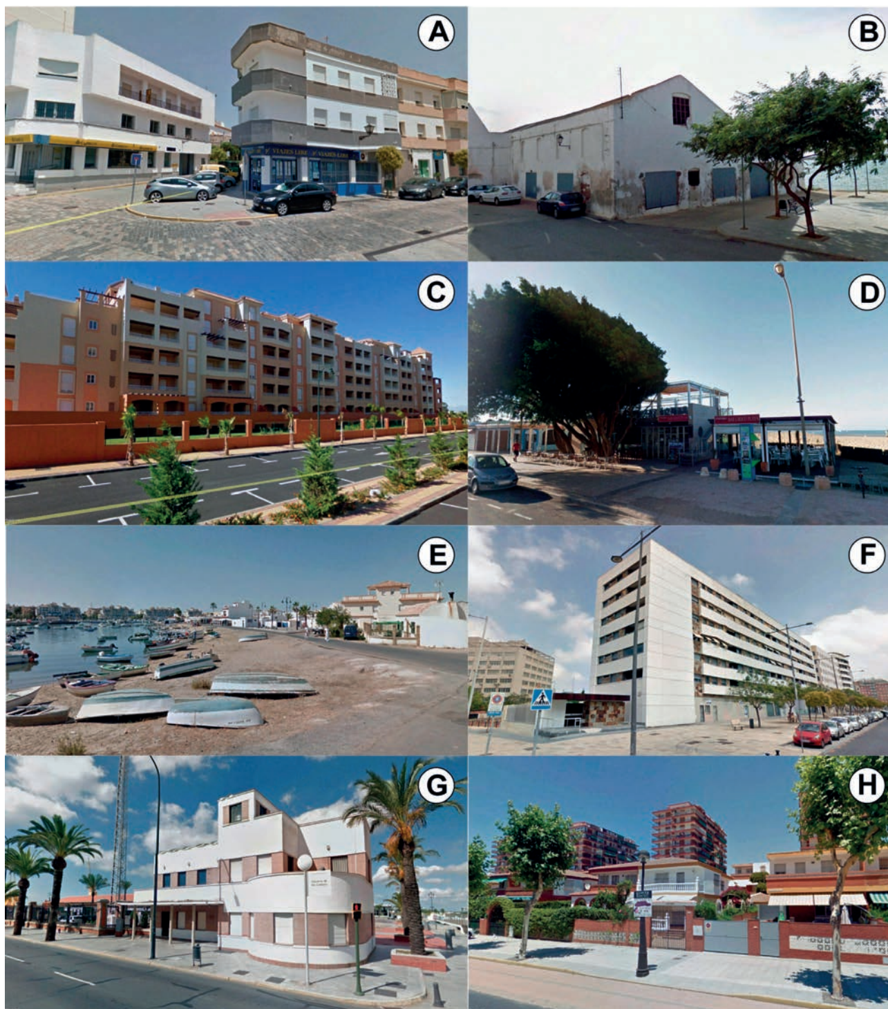
Fig. 4.- Diferente ejemplos de construcciones en las localidades estudiadas: A. Edificios con vulnerabilidad alta en Ayamonte; B. Construcción destinada al almacenaje en mal estado de conservación con vulnerabilidad muy alta en Ayamonte; C. En primer plano, viviendas típicas andaluzas de vulnerabilidad alta en Isla del Moral y al fondo edificios modernos de apartamentos de playa con vulnerabilidad baja; D. Edificios modernos de apartamentos de playa con vulnerabilidad baja en Isla Canela; E. Construcción de material ligero en primera línea de playa en Isla Canela con vulnerabilidad muy alta; F. Construcción de muy baja vulnerabilidad en las proximidades del cauce del Río Odiel en Huelva; G. Construcción de vulnerabilidad alta en la zona portuaria de la ría de Huelva; H. En primer plano, viviendas unifamiliares en Punta Umbría con vulnerabilidad media y al fondo edificios de más de 5 plantas con vulnerabilidad muy baja.
