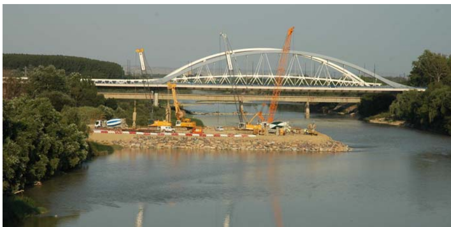
Las obras del azud en su fase inicial (verano de 2006)
