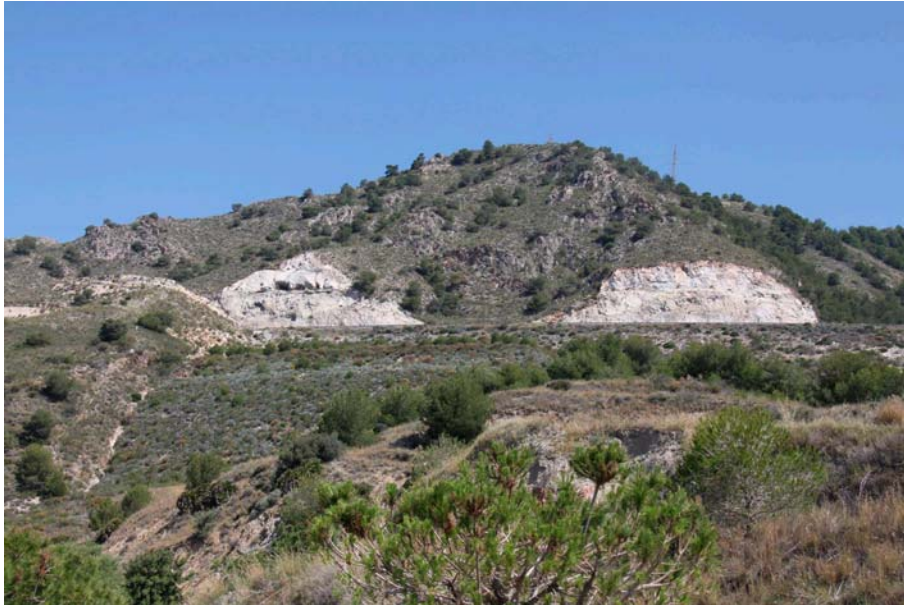
Figura 5. Taludes generados por la autovía A7 en el entorno litoral. Elaboración propia.
