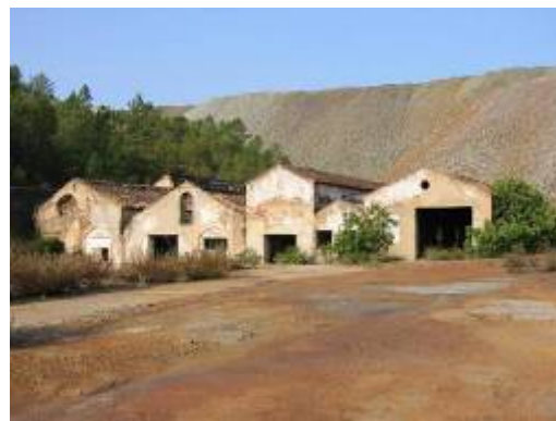
Foto 4. Almacén Mina (E. Romero)
