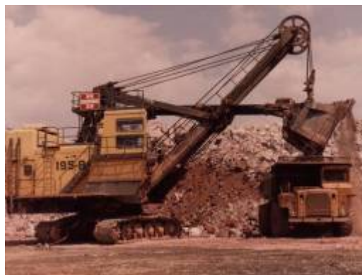
Foto 12. Excavadora década de los 80
