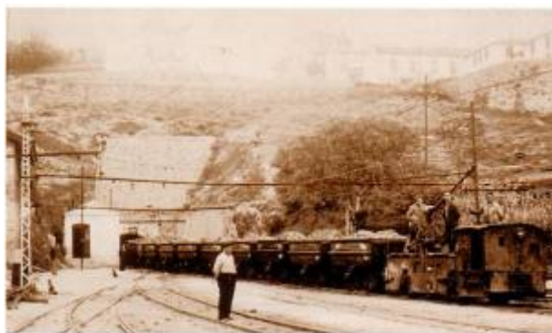
Foto 13. Locomotora saliendo del túnel Naya (Archivo F.R.T.)
