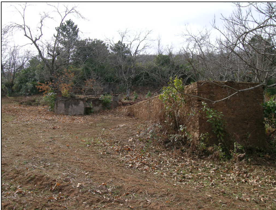
Figura 7. Aspecto actual del socavón principal de la mina San José (arriba) y del antiguo lavadero de mineral (abajo).
