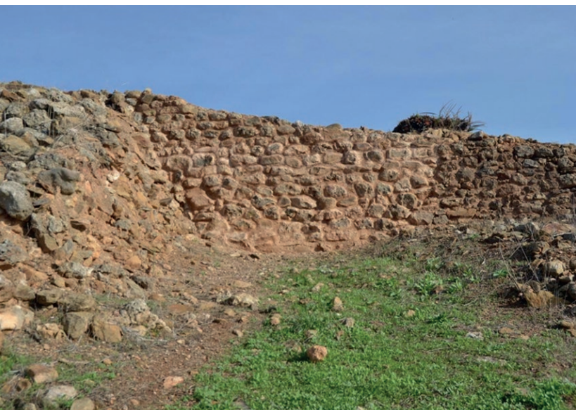
Figura 21 Detalle de la muralla con el lienzo restaurado.
