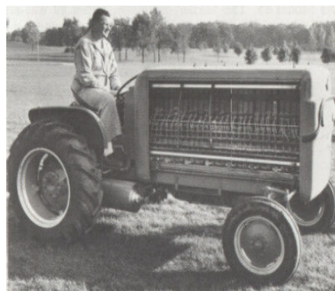
Figura 2.4: Tractor Allis Chalmers con pila de combustible, 1959.
