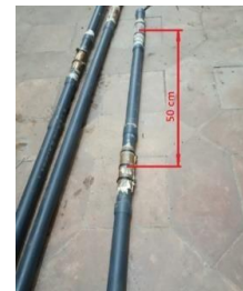
Fig. 5. Fig. 2: Distribución de los sensores a lo largo del tubo de PVC en los primeros 3 metros.
