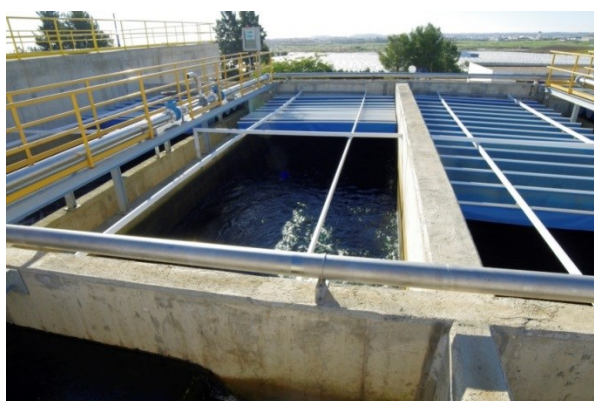
Fig. I.16 Filtro carbón activo granular -GAC-
