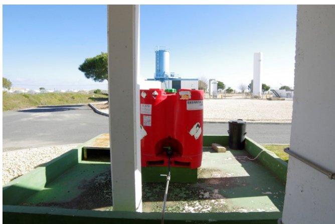
Fig. I.18 Dosificación H_2O_2 en AOP ( O_3+H_2O_2 )
