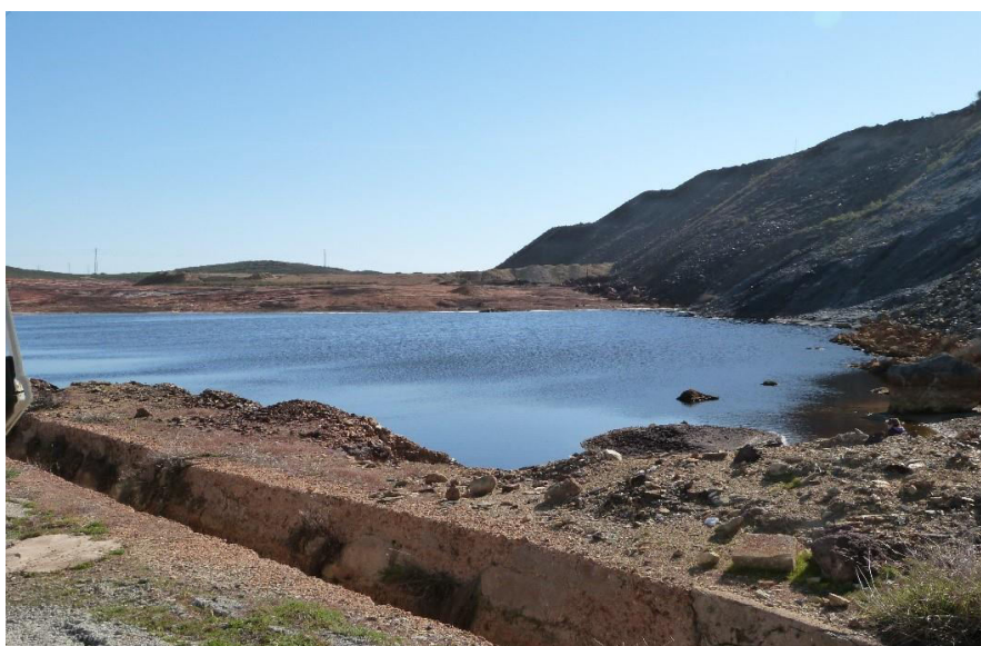
Figura 2.10 Embalse Aguas Ácidas
