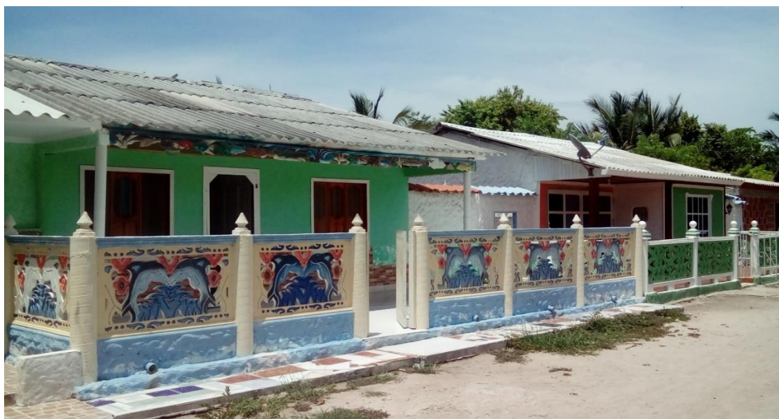
Figura 8. Casa típica de ladrillos en Isla Grande
