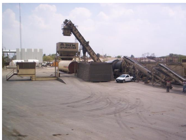
Ilustración 36. Planta de asfalto.
