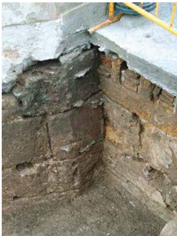
Lámina 7. Detalle del punto de contacto entre la coracha y el cuerpo principal de la Torre del Oro (fotografía cortesía de Enrique Domínguez).
