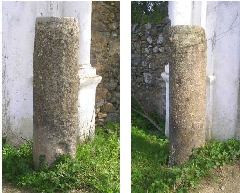
Fig. 177. Fustes de columna procedente del campus , reaprovechados en la portada de la finca La Belleza.
