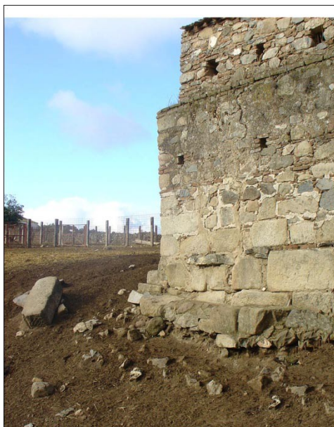
Fig. 208. Cimentación de sillares de una construcción en la ermita de Santa Clara.
