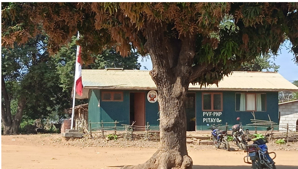
Puesto de Vigilancia Fronteriza del caserío de Pitayo
