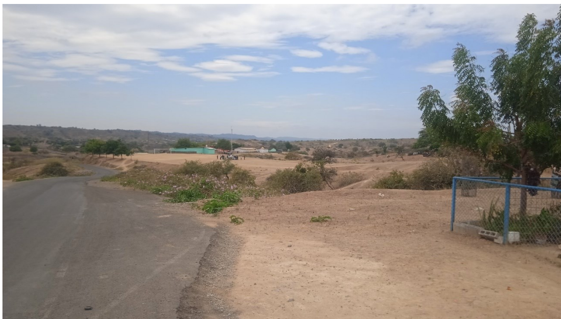
Caminos que unen caseríos en zona de frontera, distrito de Lancones
