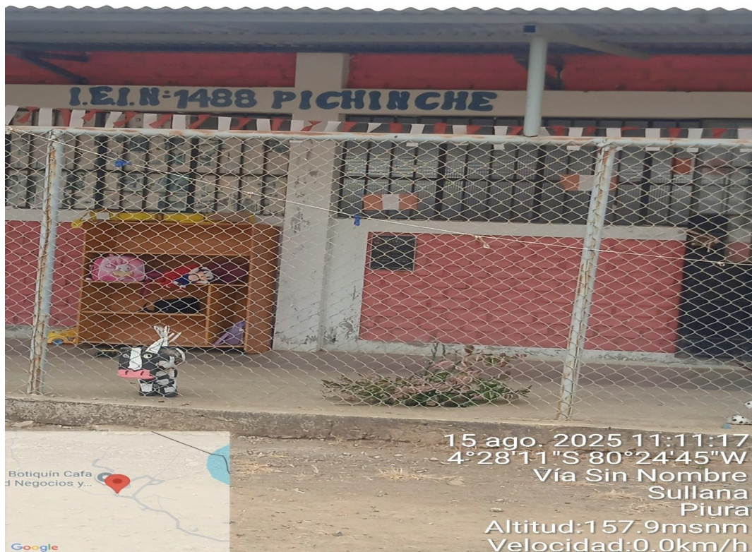
Colegio de nivel inicial Caserío Pichinche
