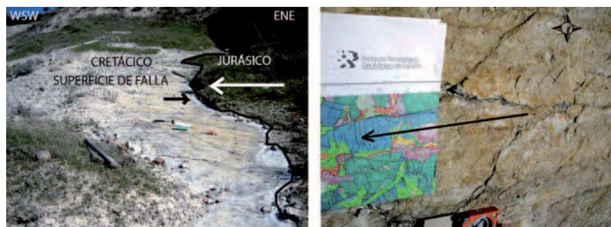
Fig. 4.- A: Plano de falla extensional de bajo ángulo que afecta a niveles de margocalizas cretácicas previamente cabalgadas por calizas jurásicas. B: Detalle del plano de falla en el que se aprecian las estrías y los dos juegos de diaclasas extensionales.
