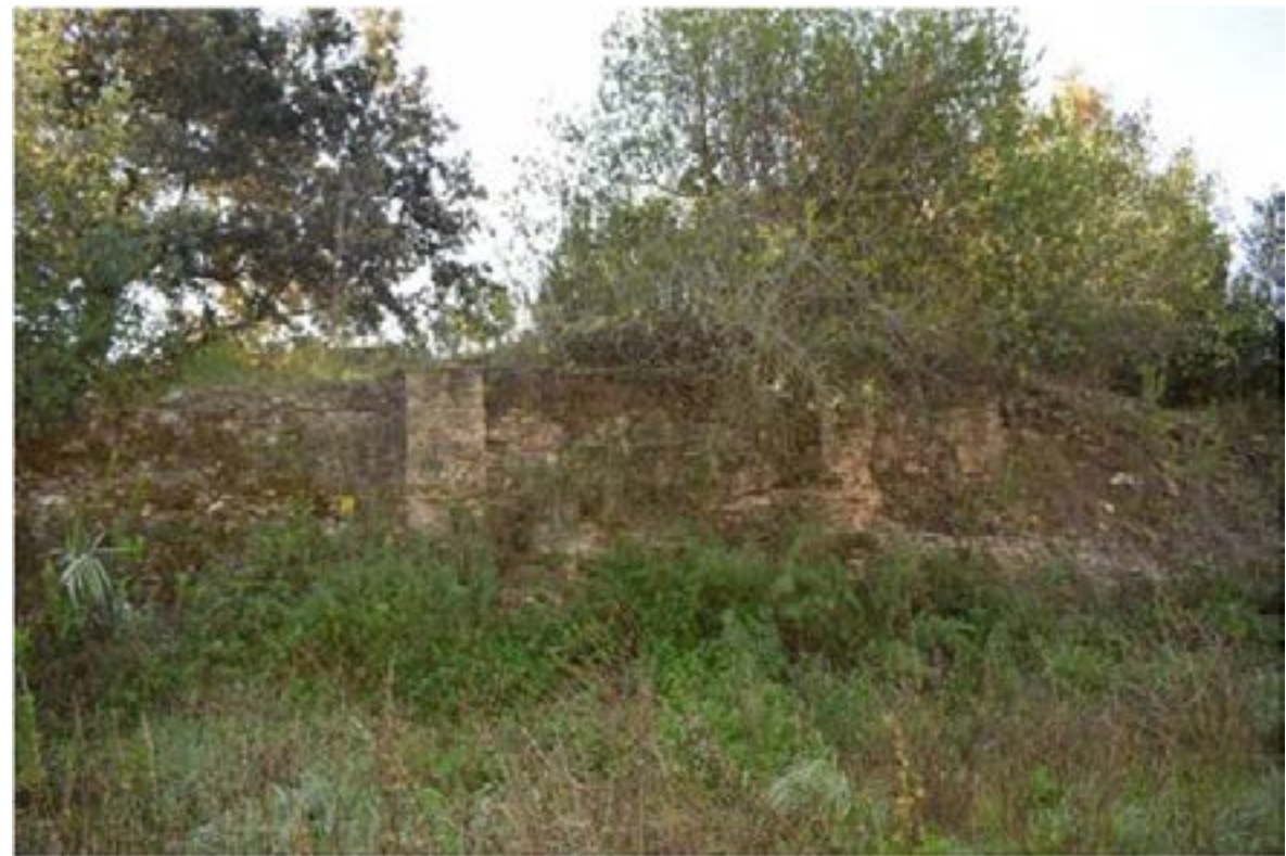
Figura 2. Estructuras en la zona superior del muelle.
