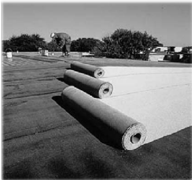
Figura 2.4 Láminas de impermeabilización.
