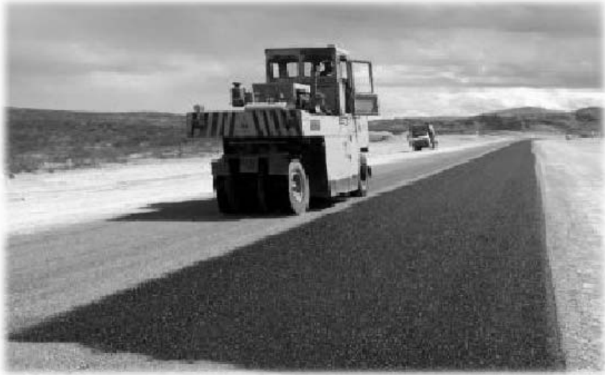
Figura 2.5 Ejemplo de uso de betún en pavimentación de carreteras.
