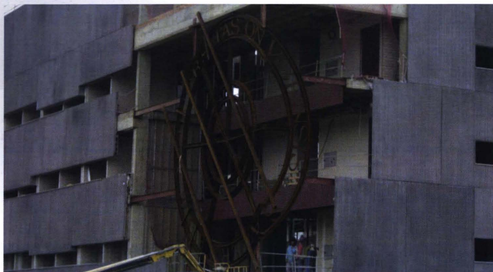
Edificio en construcción. Campus de El Carmen.
