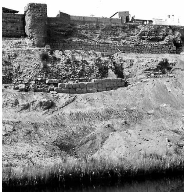
Figura 3. El “Muro de Droop”
