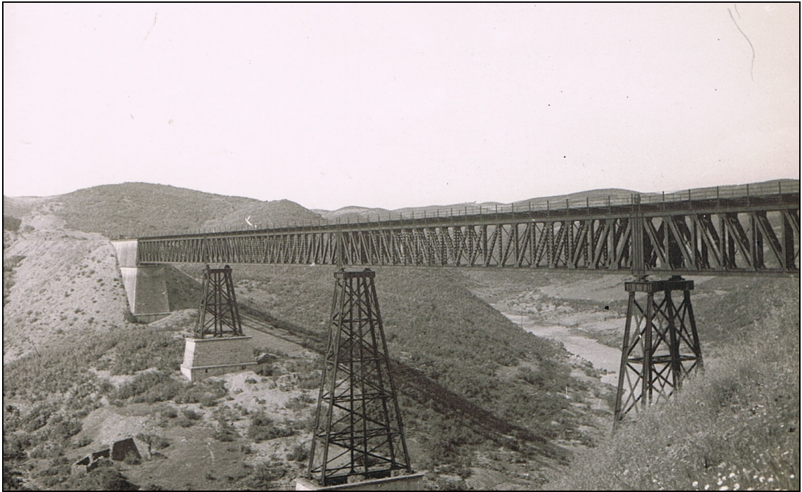
Figura 3.41. Puente del ferrocarril sobre el río Odiel (Martín Bolaños, 1942). En esta fotografía se observan las sierras de escasa elevación cubiertas de matorral, jarales principalmente, y la ribera altamente degradada. Fuente: Unidad de Botánica de la ETSIM-UPM.
