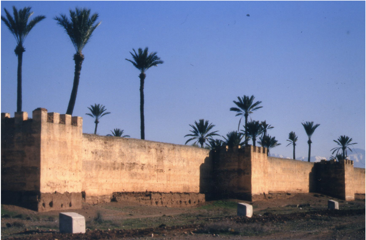
Figura 11. Vista de las murallas almorávides de Marrakech (fotografía de Daniel Jiménez). Erigidas casi al mismo tiempo que el recinto sevillano, su aspecto sería muy similar.
