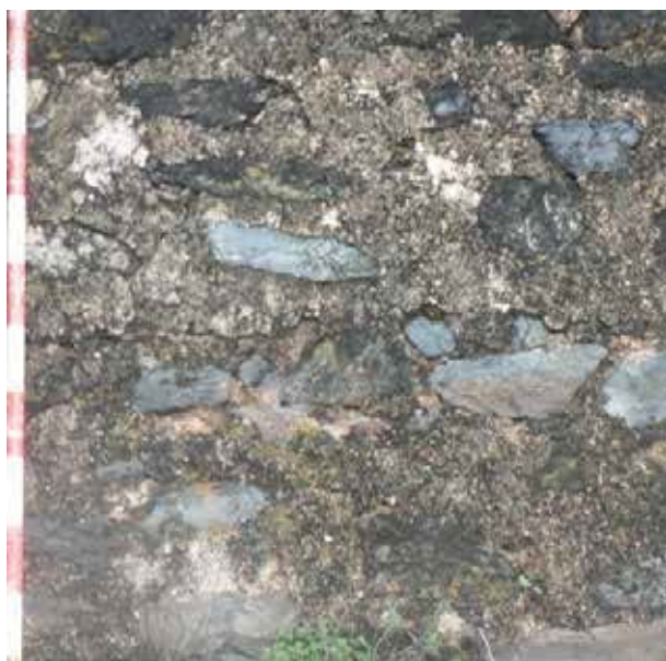
Figura 10: Detalle de la fábrica de mampostería con enfoscado a raspaterón. Suptipo 5-1.
